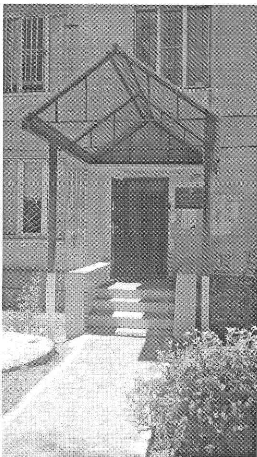
2 Вход (входы) в здание
